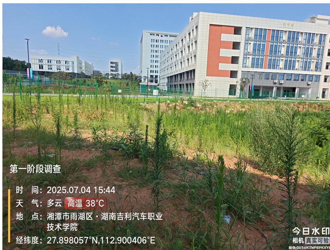
图 6.15 护潭二级渠原河道区域现状照片
